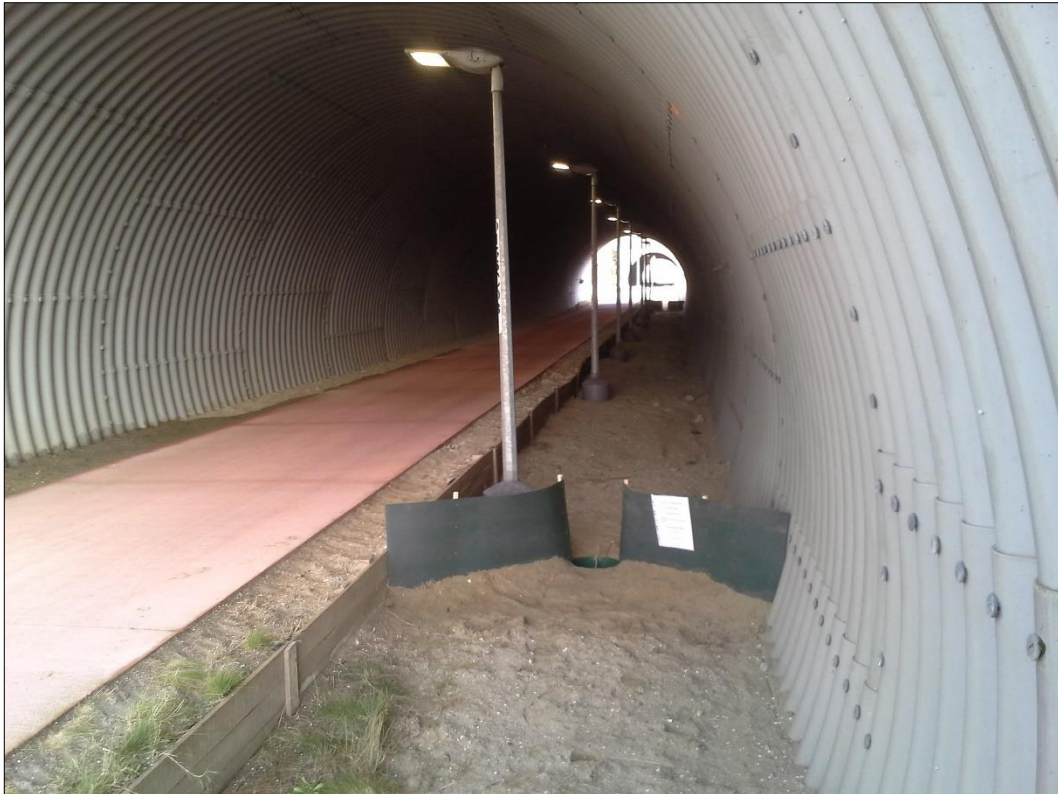
Figuur 31 Gecombineerde fiets- en faunatunnel aan het nieuw aangelegde verhoogde rondpunt van Haandorp Beveren. Foto: Johan Baetens
