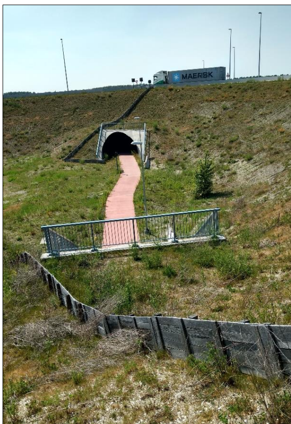
Figuur 29 Geleiding en gecombineerde fiets- en faunatunnel aan het nieuw aangelegde verhoogde rondpunt van Haandorp Beveren. Foto: Ilf Jacobs
